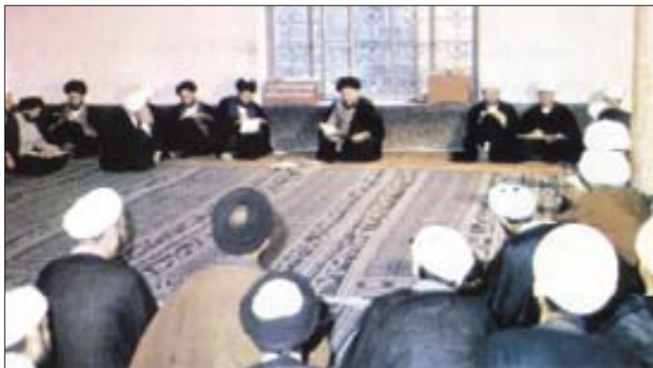
۱۳۵۰: بیعت مسجد طوسیه شهید صدر در حال تخریب
